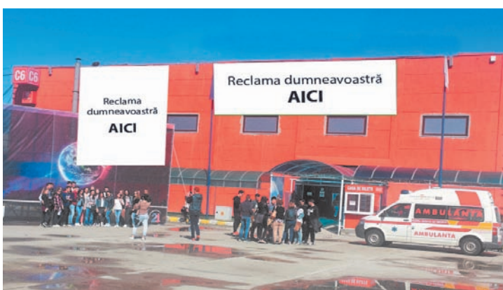
AFISARE BANNERE PE FATADA PAVILIONULUI C6
